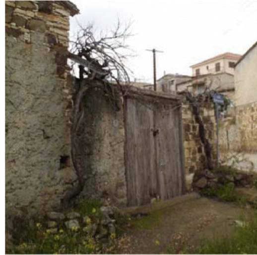
Χρήση τσιμέντου για στήριξη του τοίχου.
